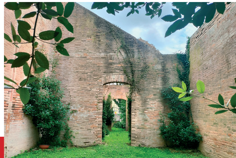
Giardino delle ex-carceri mandamentali di Copparo dove fu detenuta Alda Costa
